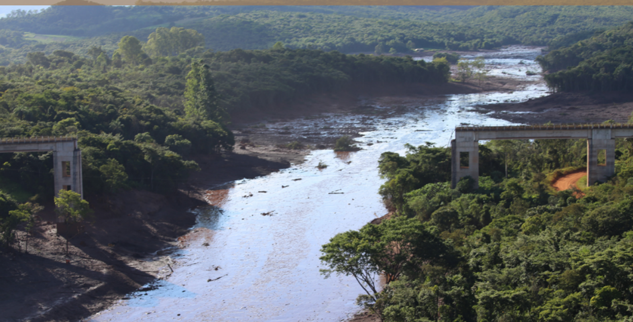
Vista aérea mostra a abrangência e a violência da destruição.
