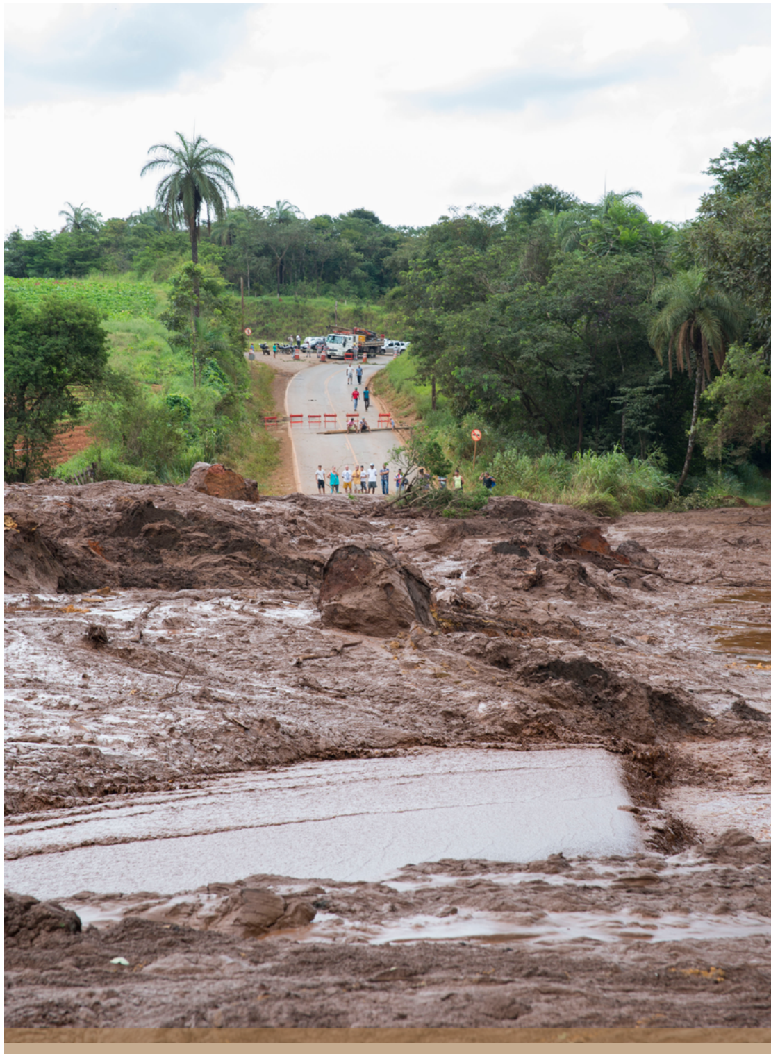
Estrada destruída pelo rompimento da barragem.
