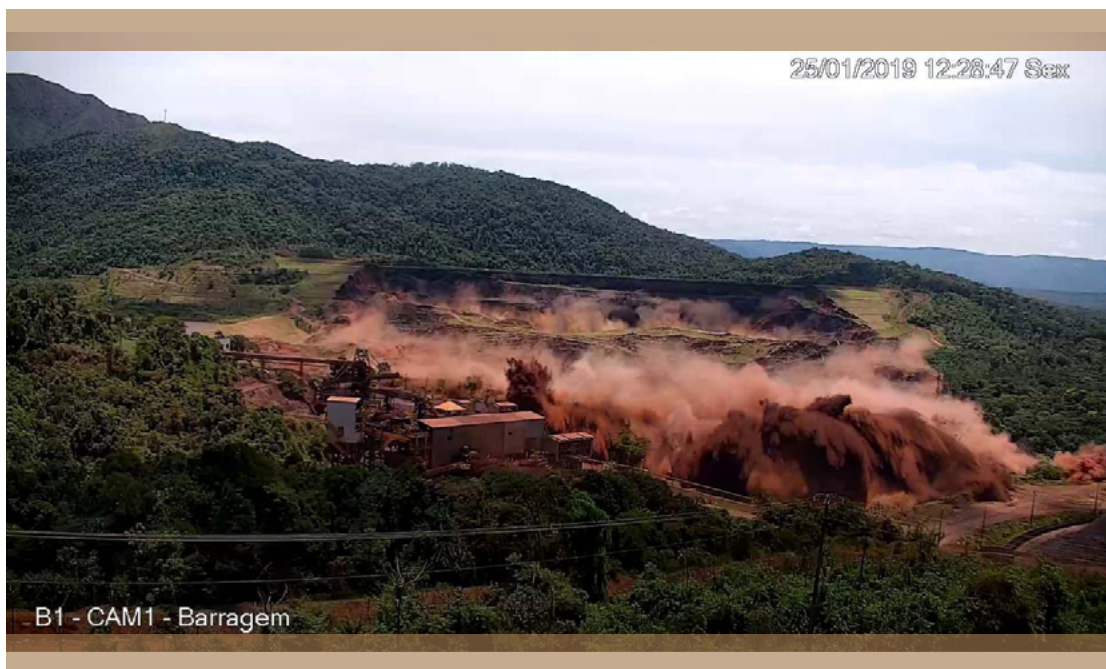
Momento da explosão da barragem. A lama vazou a uma velocidade de 21,3 metros por segundo, pouco mais de 76 quilômetros por hora. A avalanche atingiu a área operacional, o refeitório e a área administrativa em menos de meio minuto. Calcula-se que a pousada tenha sido arrastada em menos de dois minutos.
